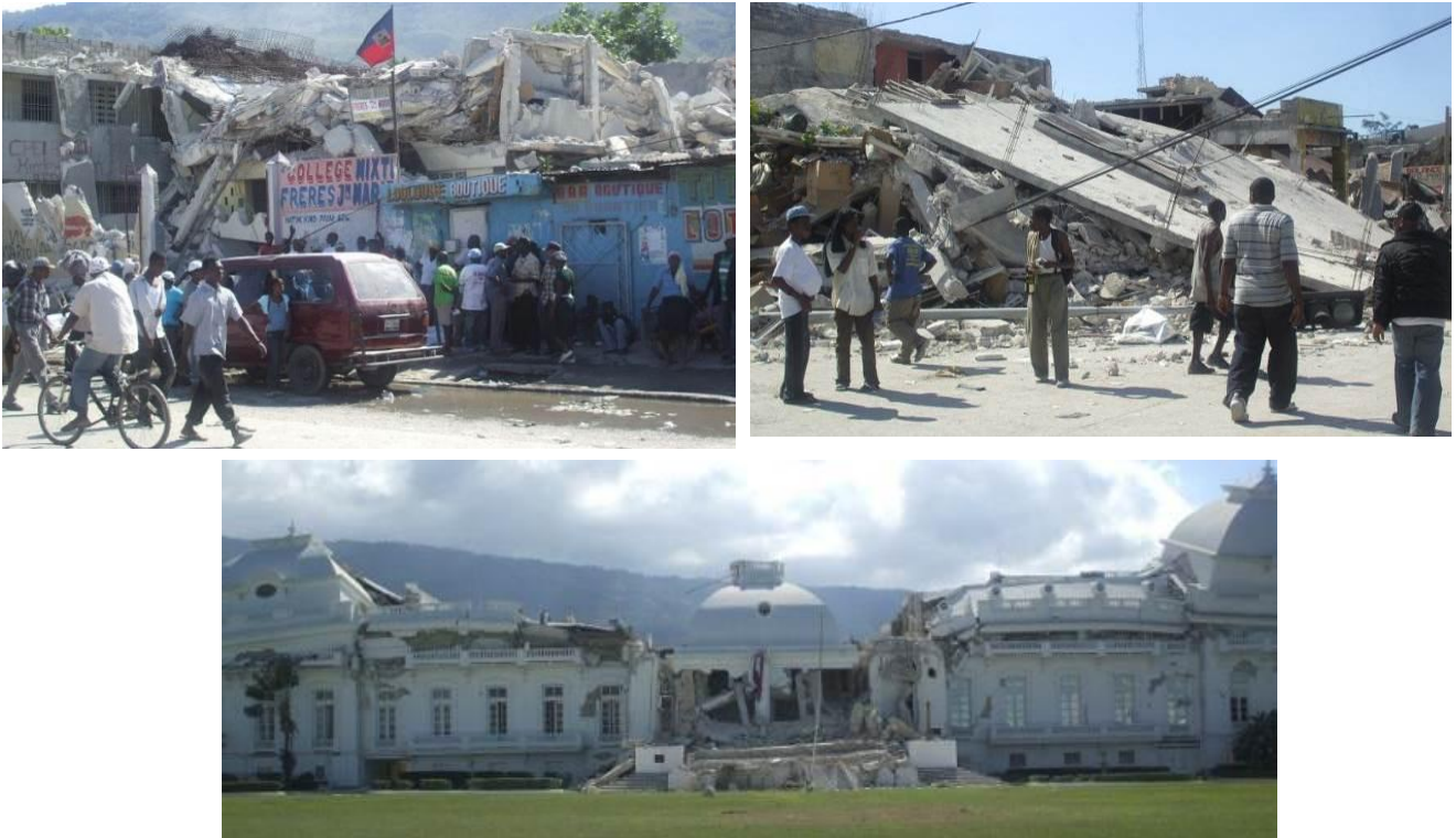
Figura 2 - Immagini di edifici distrutti dal terremoto del 12 Gennaio 2010: in alto varie case e negozi della capitale e in basso il Palazzo Nazionale.
