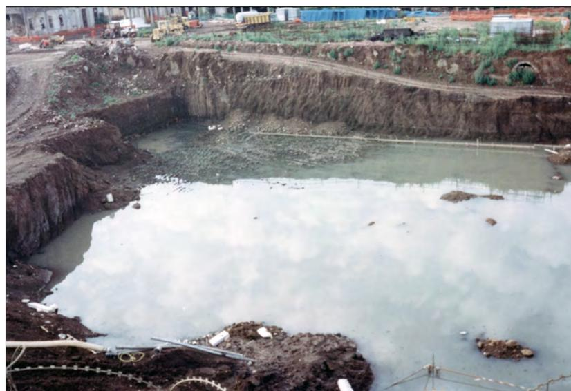
Figure 4 e 5. Immagini del cantiere scattate nel 1992 che mostrano la condotta interrata del Fosso della Marranella sulla parete di scavo sud e, sul fondo, l'emersione della falda durante i lavori
