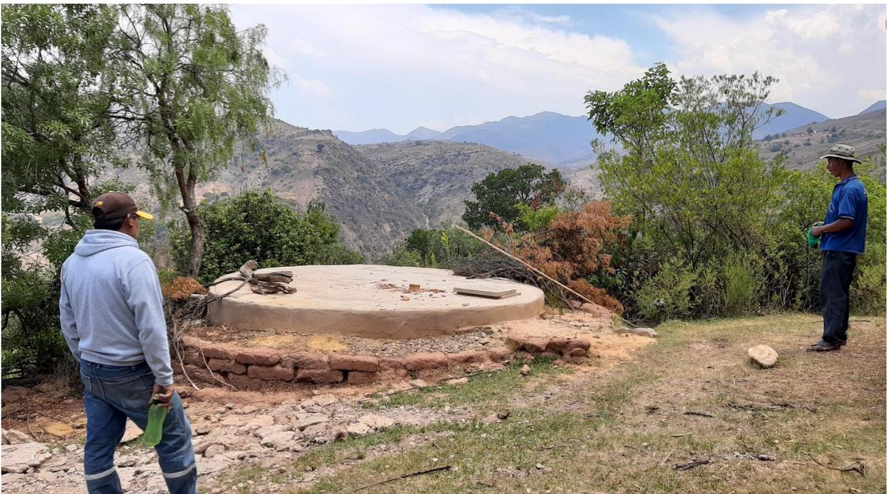
Fig.4 – Cisterna da 20 m3 per captazione idrica da sorgente
