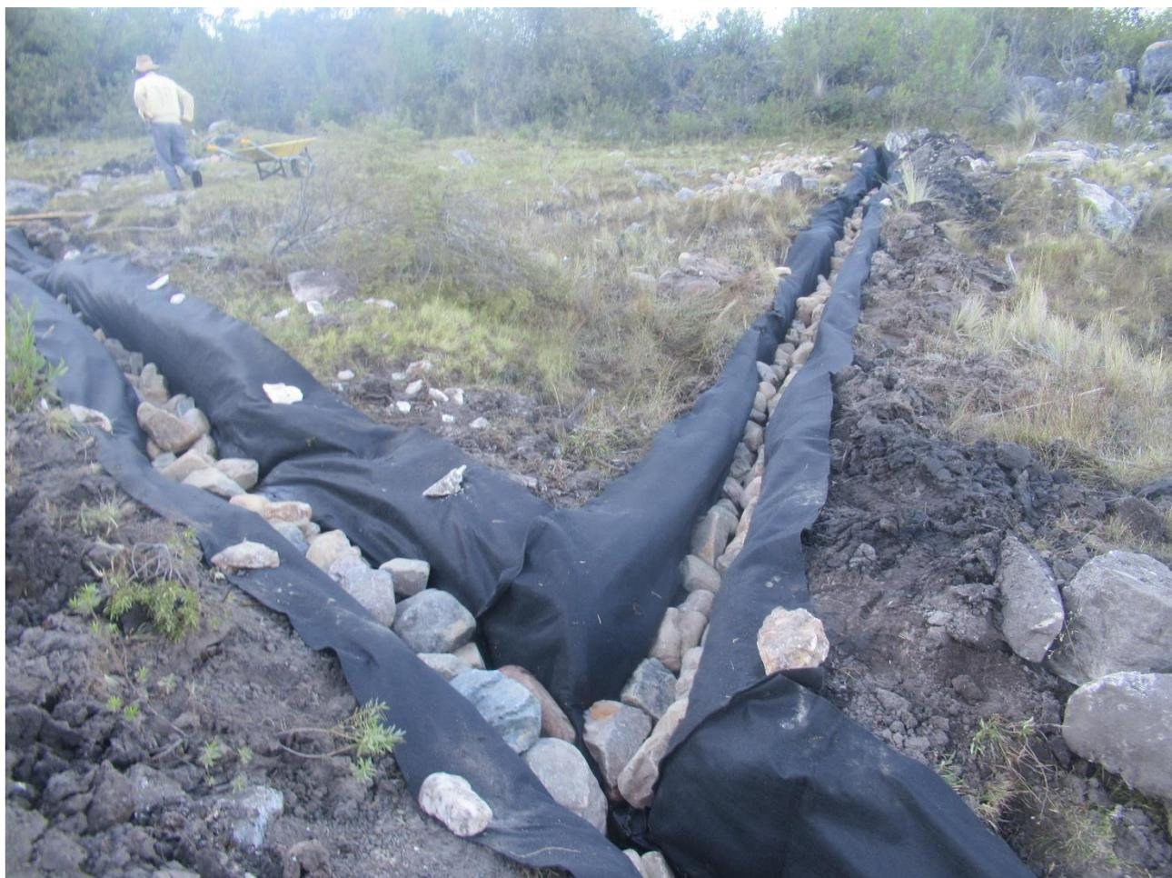
Figura 6 – Sistema di captazione da versante umido (bofedal) attraverso trincee drenanti
