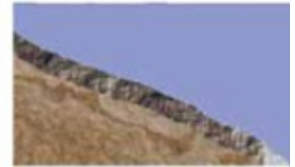
Preparación del basamento de apoyo del muro
