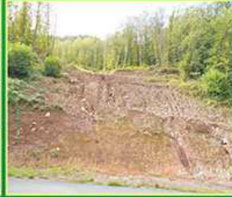
Fasi iniziali della riprofilatura di un versante franato
