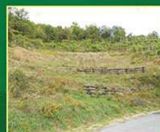
Palizzate doppie in legname, drenaggio centrale, riprofilatura con terre armate, rinverdimento (al momento dell'intervento e a 18 mesi di distanza)
