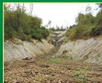
Regimazione a fascinate drenanti, briglie in legname, geostuoie biodegradabili
