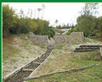
Regimazione a fascinate drenanti, briglie in legname, geostuoie biodegradabili
