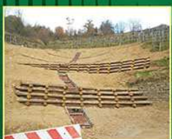
Palizzate doppie in legname, drenaggio centrale, riprofilatura con terre armate, rinverdimento (al momento dell'intervento e a 18 mesi di distanza)
