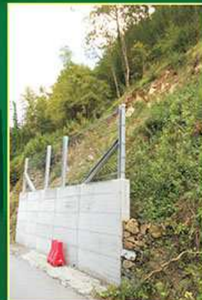
Muro di contenimento con rete paramassi
